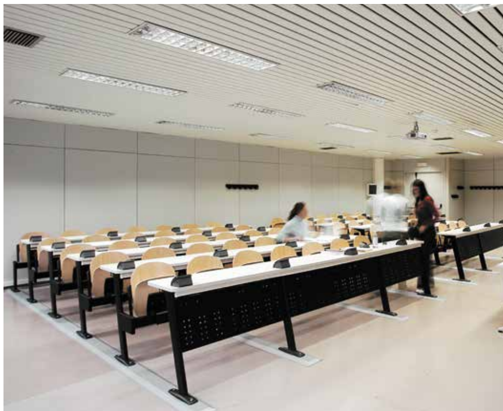
Allestimento fissato su binari che evita la foratura del pavimento e consente la eventuale cablaggio elettrico Fixed set-up on rails to avoid floor drilling and allow cable management
